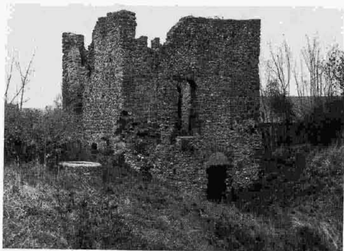
FIG. 16. — Le revers de la tour-porte du noyau fortifié, à Bois-Ruffin. Remarquer l'appareil. A gauche et à droite, le rempart de terre, et, à gauche, le puits.
