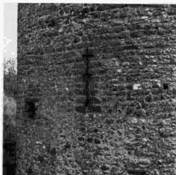
FIG. 19. — Archère à double croisillon et étrier du second niveau. A gauche, un soupirail du premier niveau.
