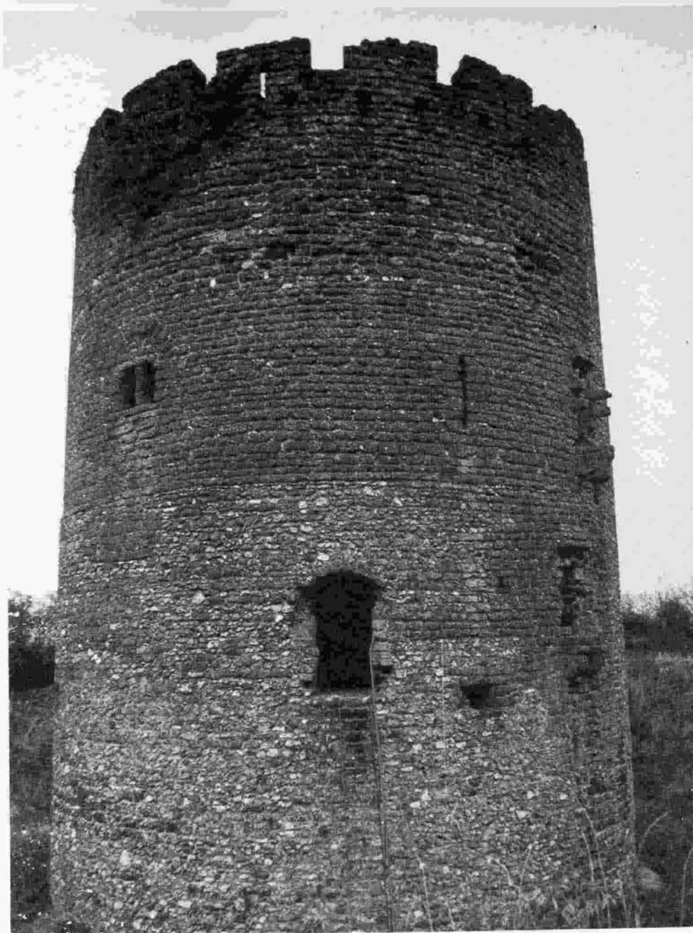
FIG. 18. — Le donjon de Bois-Ruffin, vu du sud-ouest. On remarque la poterne, les restes de latrines à droite ; au troisième niveau, la fenêtre et l'archère ; au quatrième niveau, les trous de boulins du hourdage et les archères des merlons.
